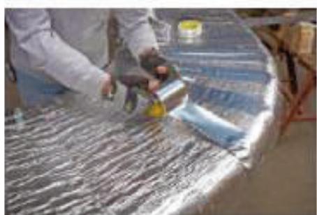
Стыки герметизируются алюминиевой лентой Joints are sealed with aluminum tape
