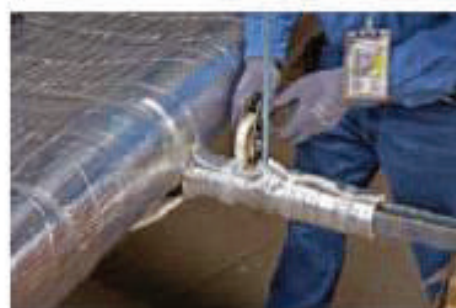
Отходящие элементы закрываются не менее, чем на 300 мм Outgoing elements are closed by at least 300 mm
