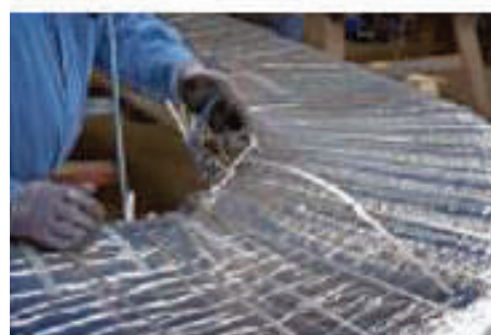
Система механически фиксируется стальной лентой The system is mechanically fixed with a steel band
