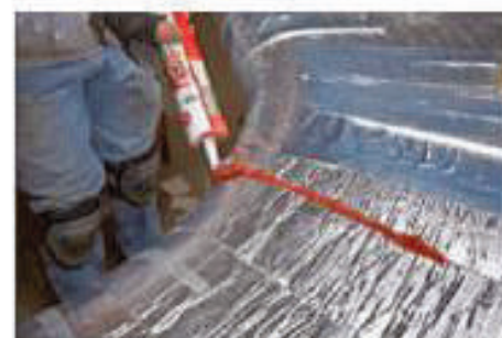
Зазоры герметизируются огнезащитной связкой и алюминиевой лентой Gaps are sealed with flame retardant binder and aluminum tape
